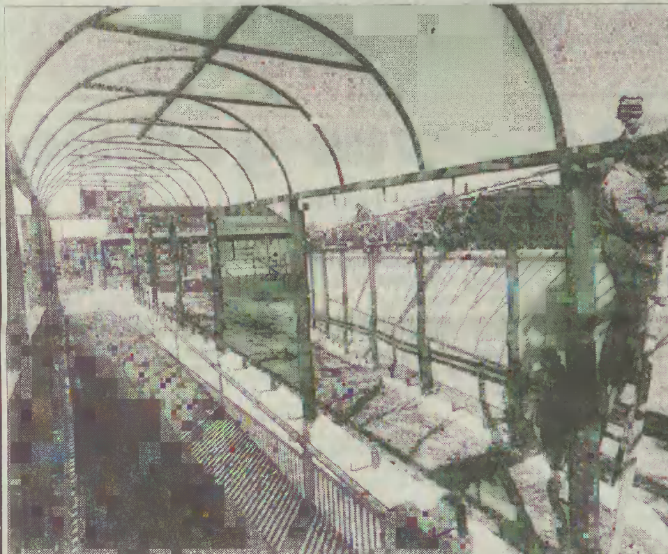
Przejścia dla pieszych, biegnące pod budowanym obecnie odcinkiem drogi wylotowej na Warszawę, nabierają końcowego kształtu. To, pod wełnem przy skrzyżowaniu ulic Elbląskiej, Sienkiewicza i Długie Ogrody, zaprojektowane zostało i sprężonym żelazem i dobrem oświetleniem.
