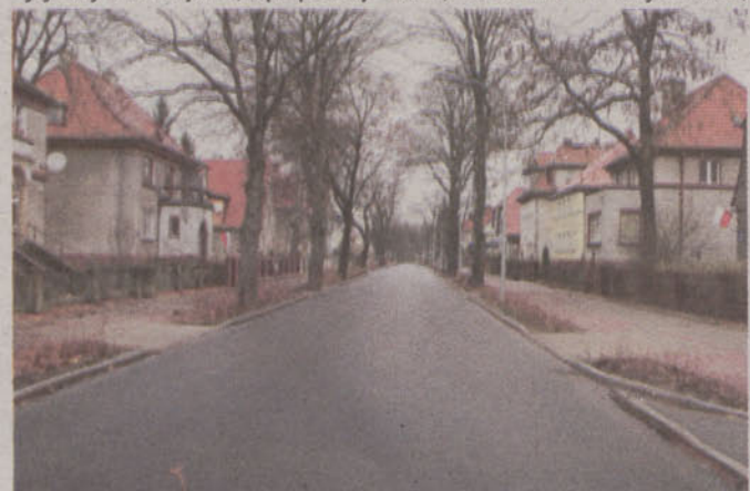
Ulica Arciszewskiego widok z roku 2010, po remoncie.
