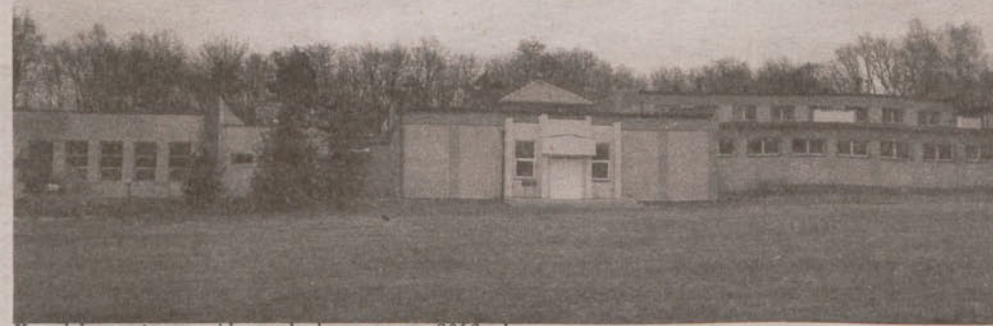
Kompleks sportowy z widoczną budową- marzec 2016 rok.
