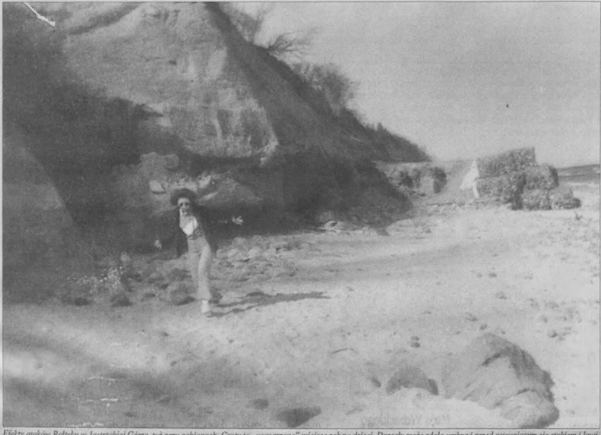
Fekty ataków Bałtyku w Jastrzębiej Górze, tuż przy gabionach. Groty to „wymarzone” miejsce zabaw dzieci...
