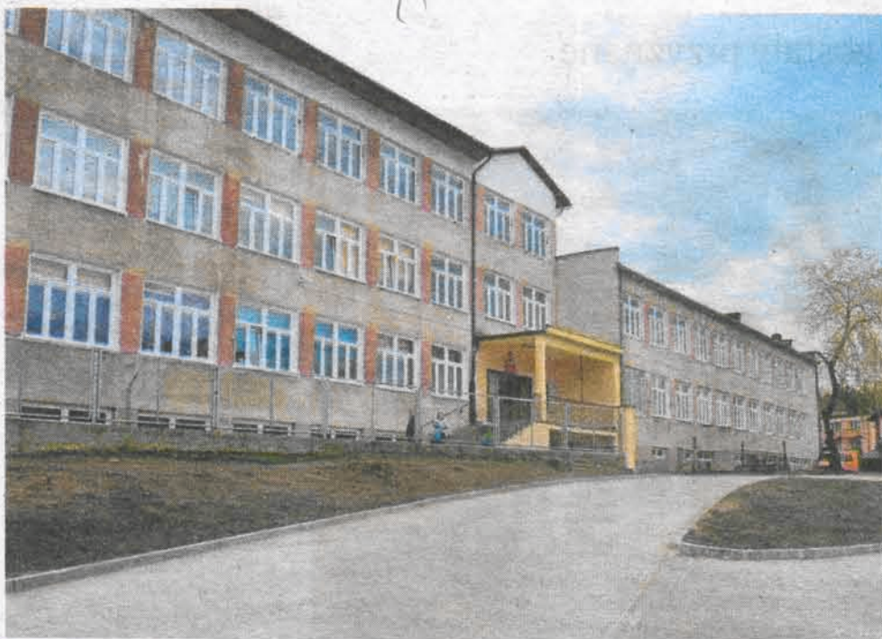
Niebawem prace termomodernizacyjne rozpoczną się w Szkole Podstawowej w Kępicach. Mają się zakończyć do września
