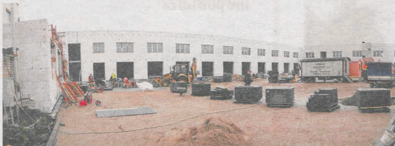
Krat-Met buduje aktualnie nowe obiekty przy ul. Witosa w Kobylnicy. Pomieszcza centrum szkoleniowe, firmowy salon sprzedaży oraz halę produkcyjno-magazynową
