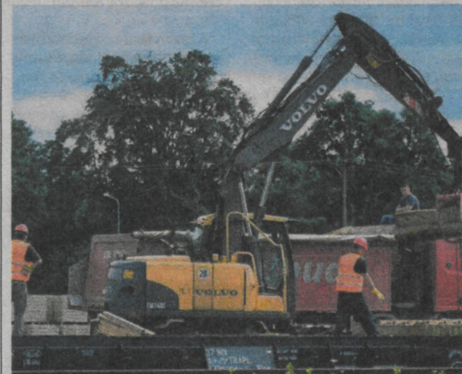
► Remont linii kolejowej nr 405 powoduje utrudnienia w gminie Kępice. Na kłopoty z przejazdem drogowym skarży się wieś Żelice
