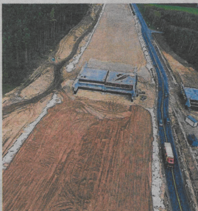
► Przetargi na budowę dróg w kraju mogą przynieść oszczędności. Na zdjęciu budowa S6 koło Sianowa
