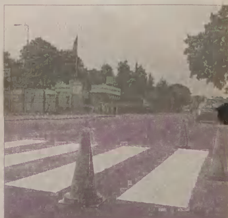
Pracownicy Zarządu Dróg Wojewódzkich w Gdańsku malują na drogach wojewódzkich, biegnących przez teren powiatu nowodworskiego, znaki poziome. Biały kolor poprawi poziom bezpieczeństwa na drodze.
