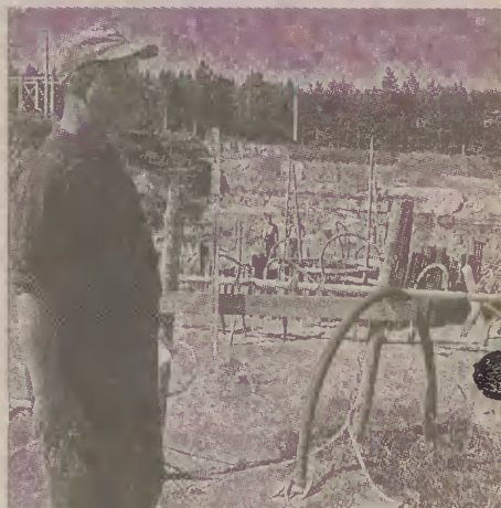
W Steganie trwają prace modernizacyjne oczyszczalni biologiczno-mechanicznej, oddanej do użytku w 1987 roku. Dyrektor Spółki Wodnej Mierzeja Cezary Malinowski przewiduje, że koszt inwestycji wyniesie około 10 mln zł. Na zdjęciu: Robert Tyburski, dyspozytor oczyszczalni ścieków w Spółce Wodnej Mierzeja.
