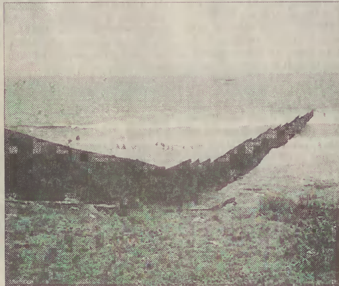
Stalowy parkan schodzi na plażę, na kilkadziesiąt metrów wchodzi nawet w morze
