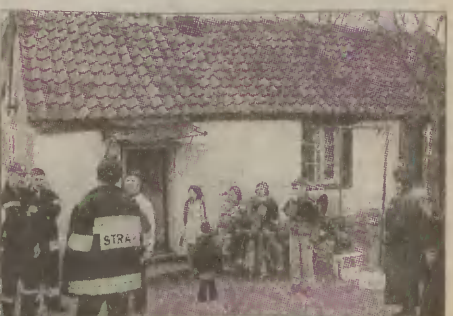
Budynek, w którym zawałił się komin, trzeba będzie rozebrać.
