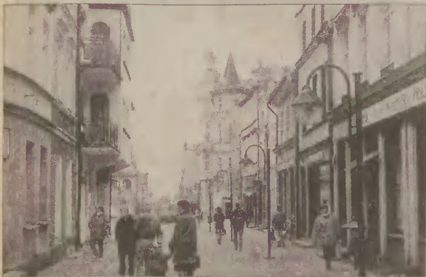
Na Starym Mieście położono nowe nawierzchnie ulic i wymieniono oświetlenie.
