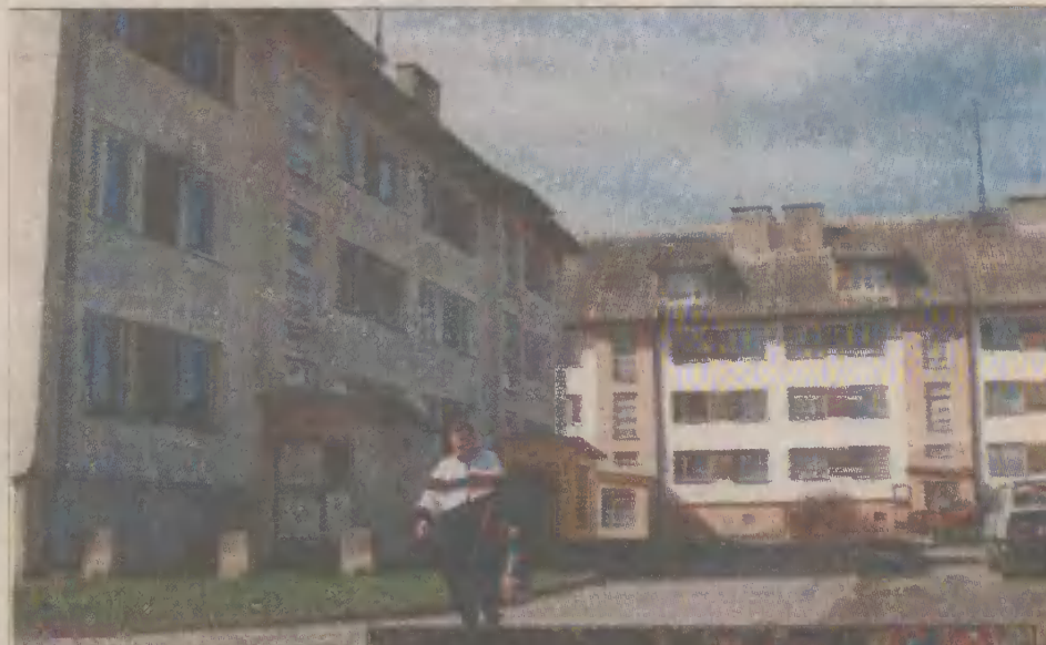
Bloki na Osiedlu Młodych wybudowano na początku lat osiemdziesiątych.
