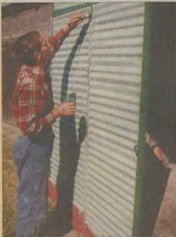
Andrzej Śledź, mieszkaniec osiedla, sam postanowił wyremontować garaż.
