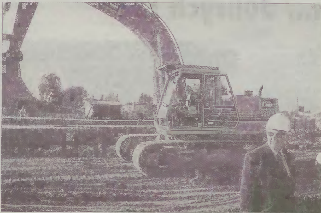
Tomasz Rzepka, inżynier budowy, na placu budowy tczewskiego Flextronicsu.
