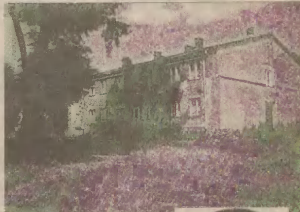
Dworek Hillarów w Piesienicy, w którym spędziła dzieciństwo Małgorzata. Stan z 1997 roku.
