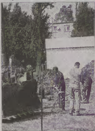
Prace przy budowie kanalizacji w Starym Polu, prowadzone są obecnie przy Urzędzie Gminy.
