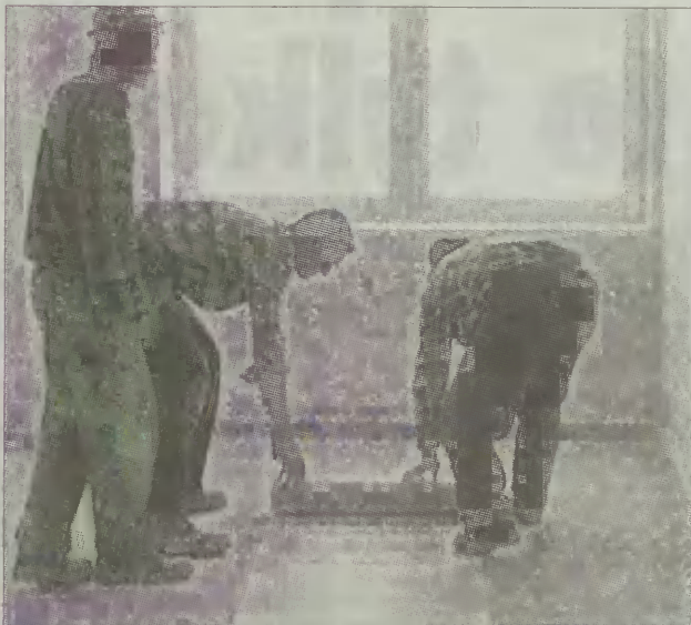
Pracownicy chojnickiego PeBeRolu układają już wykładzinę na szpitalnych korytarzach.
