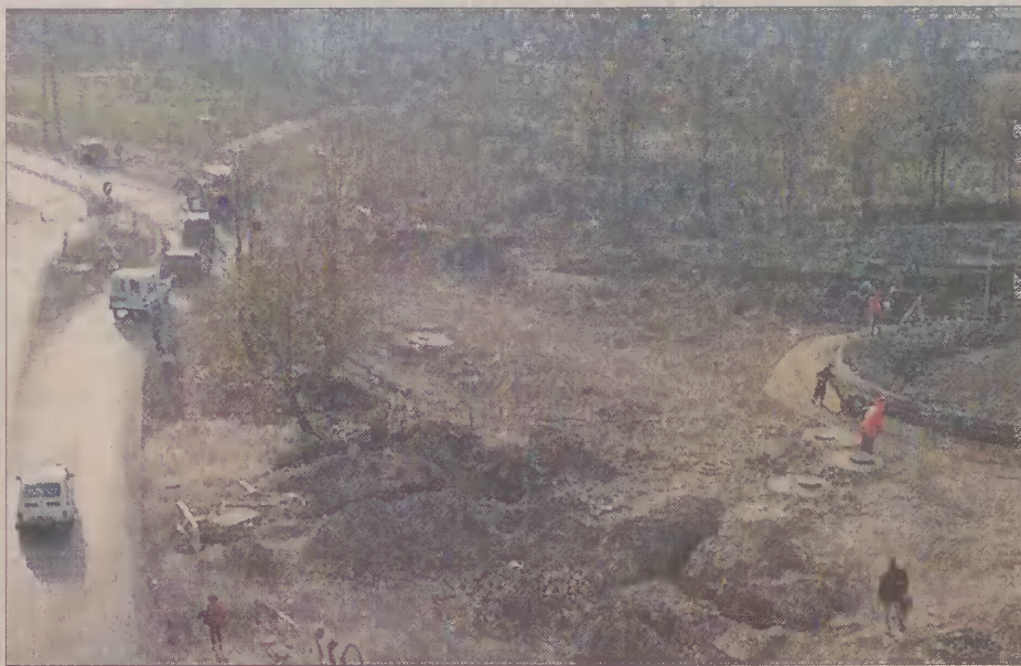
Rondo powstaje na trasie E-22 w Chojnicach.
