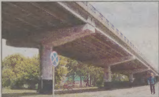
Najpilniejszą inwestycją w Pruszczu jest budowa drugiego wiaduktu.
