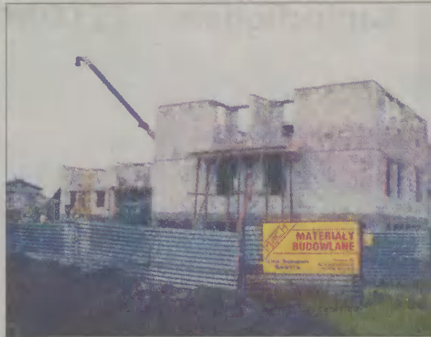
Budowę centrum usługowo - mieszkaniowego na osiedlu Wschód prowadzi firma Mach.
