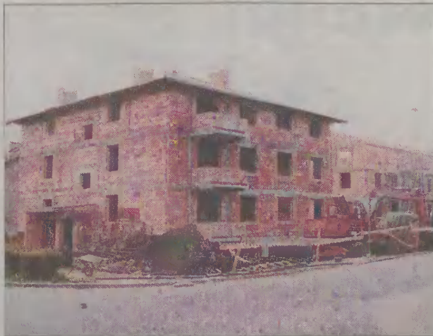
Budowa na Osiedlu Pastelowym została wstrzymana na półtora roku. Klucze - w III kwartale br.
