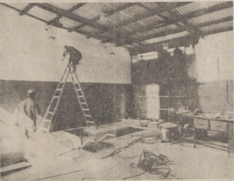
Na zdjęciu: pracownicy Oddziału Budowlano-Montażowego WZSR w Bytowie podczas prac wykonawczych
