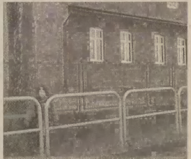
W Rekowie dzieci mają zabezpieczoną drogę do szkoły. Zamontowano przy szkole bariery ochronne.
