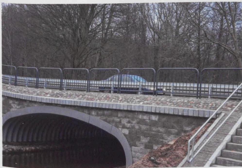
Modernizacja przepustu drogowego w Kwakowie.
