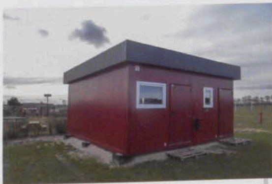
.Zaplecze szatniowo-sanitarne boiska sportowego w Kuleszewie.
