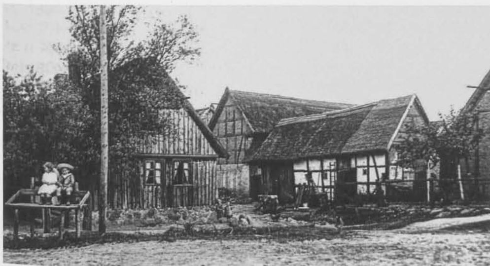
XIX-wieczne zabudowania na wsi kobylnickiej.
