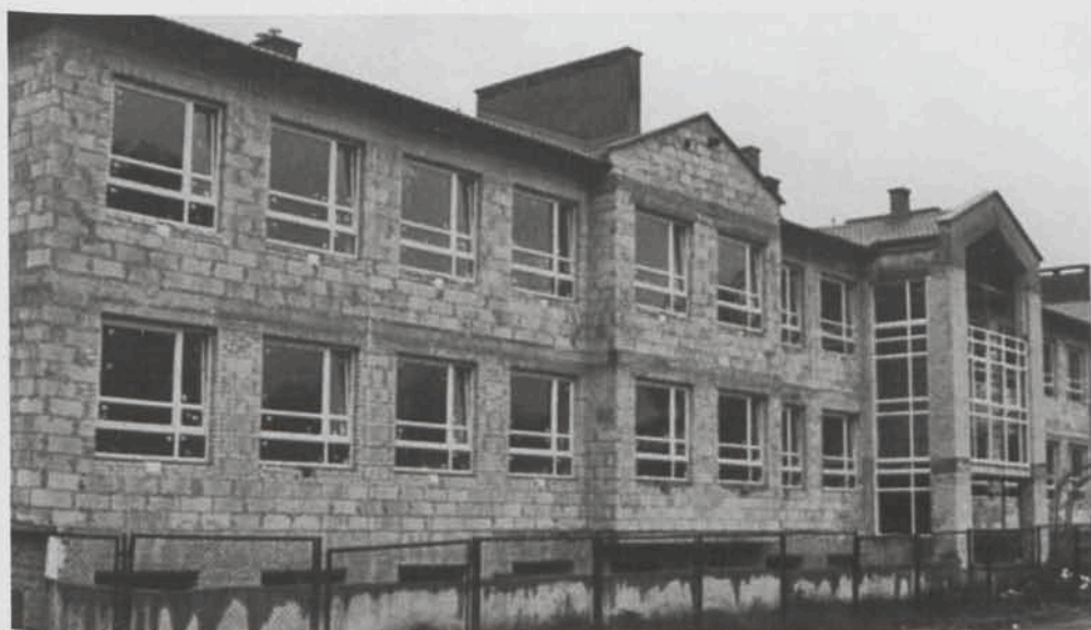
Budowa Szkoły Podstawowej w Kobylnicy (rok 1998).
