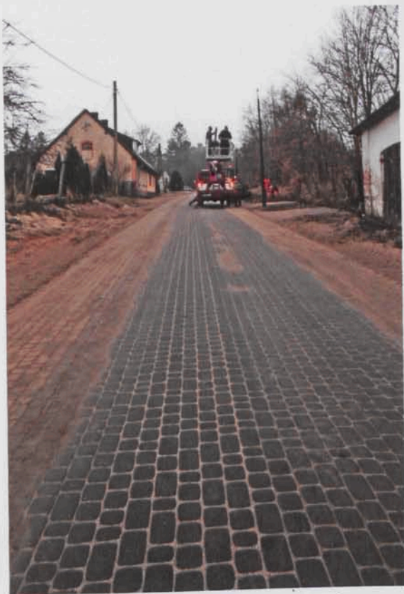
Budowa drogi nowej w Ściegnicy. Fot. Andrzej Obecny
