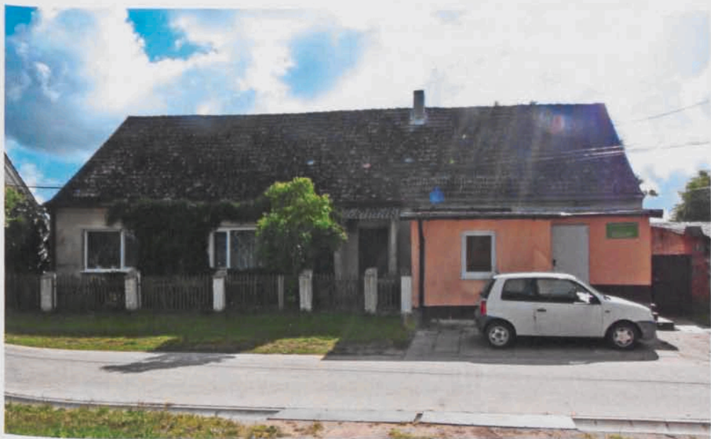
Budynek dawnej szkoły podstawowej w Komorczynie (widok dzisiejszy). Fot. Andrzej Obecny.
