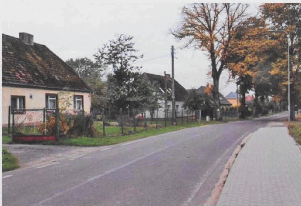
Widzino – stara zabudowa poniemiecka (widok współczesny). Źródło: kobylnica.pl.
