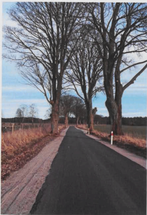
Fragment wyremontowanej drogi z Zagórek do drogi Łosino-Barcino. Fot. Andrzej Obecny.
