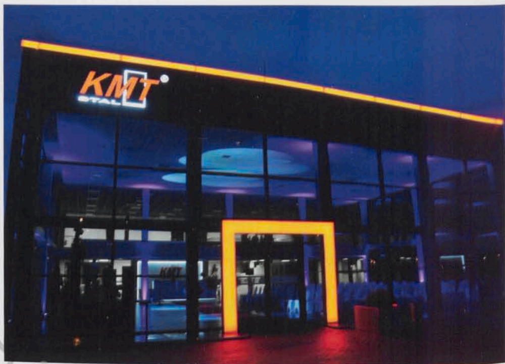
KMT – Jeden z bardzo wielu zakładów pracy w gminie Kobylnica.
