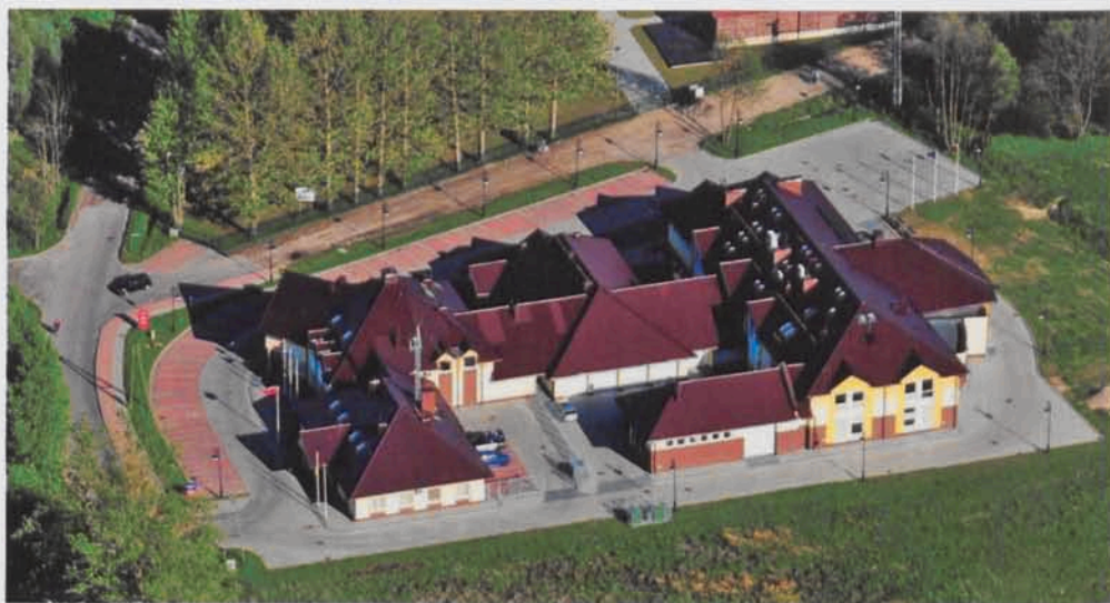
Kompleks budowlany przy ulicy Wodnej 20, w którym siedzibę mają: Gminne Centrum Kultury i Promocji, Gminna Biblioteka Publiczna, Straż Gminna, Policja, Centrum Usług Wspólnych, Ośrodek Pomocy Społecznej.
