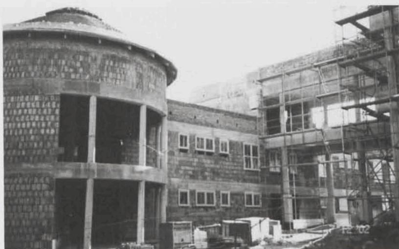
Budowa hali sportowo-widowskowej im. Bronisława Malinowskiego w Kobylnicy
