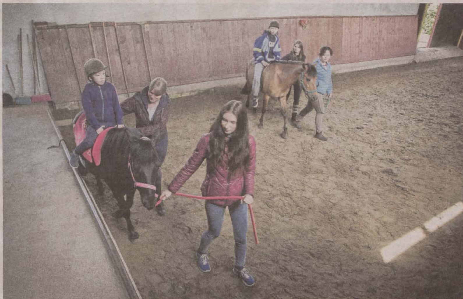
► Zajęcia z hipoterapii dla podopiecznych Nadziei odbywają się w starym pawilonie, którego dach jest tak dziurawy i zniszczony, że gdy wieje wiatr, pada ulewny deszcz czy grad, trzeba skracać zajęcia
