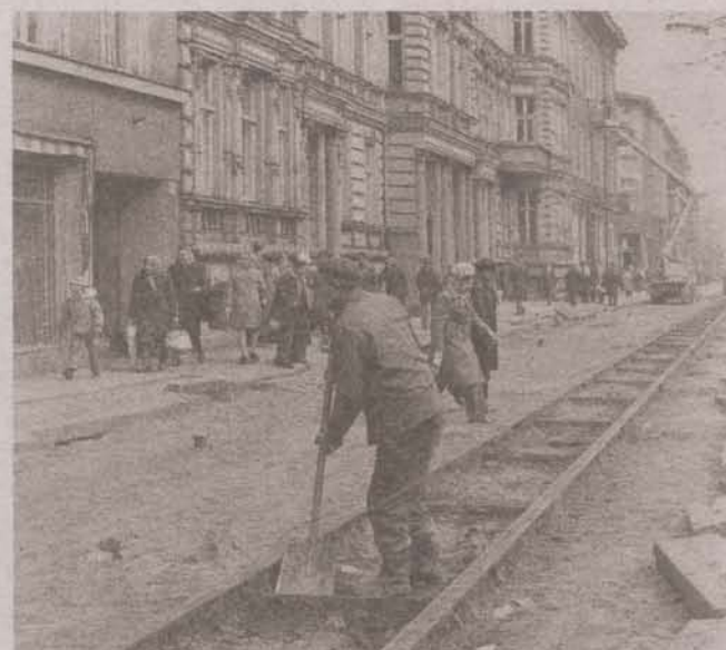
Marzec - kwiecień 1976 r., wykopywanie i usuwanie z al. Wojska Polskiego szyn po zlikwidowanej trakcji tramwajowej
