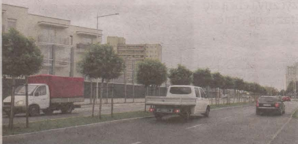
➤ Awaria kabla spowodowała, że na ul. 11 Listopada i Piłsudskiego od jakiegoś czasu nie działa część latarni. Usterka została już zlokalizowana i niebawem ma zostać usunięta
