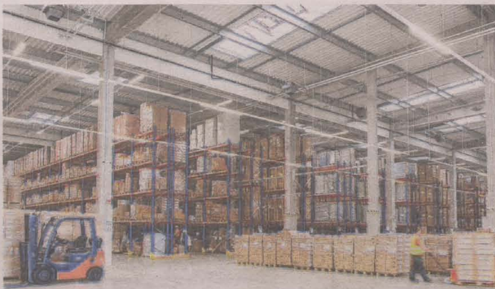
► Centrum Logistyczne Invena Log w Koszalinie (ul. Grabskiego)
