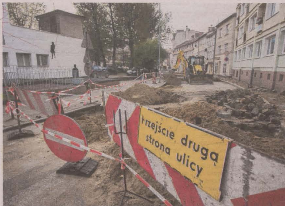
► Ulica Piekielko ma zyskać nową nawierzchnię do połowy grudnia tego roku
