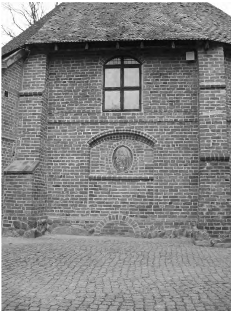
Ryc. 7. Kościół św. Gertrudy w Darłowie. Elewacja południowa. Fot. K. Kontowski, 2018 rok
