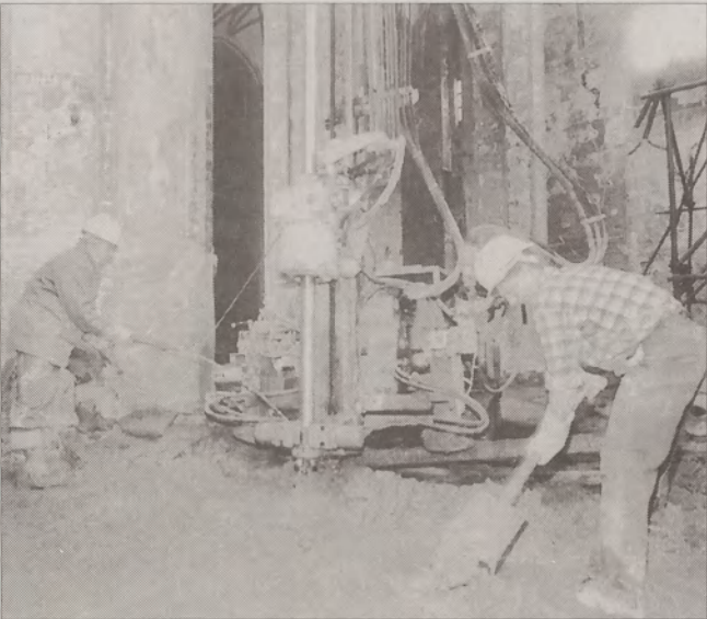
Proces umacniania fundamentów polega na wypukliwaniu, przy pomocy strumienia wody pod ciśnieniem 350 atmosfer, zniszczonej struktury gruntu, by na jej miejsce wstrzyknąć zaczyn cementowy.
