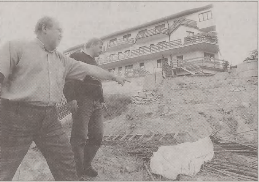
Mieczysław Fortuna i Waldemar Prugar przy obsuwającej się skarpie przy ul. Niedźwiednik 32 a w Gdańsku
