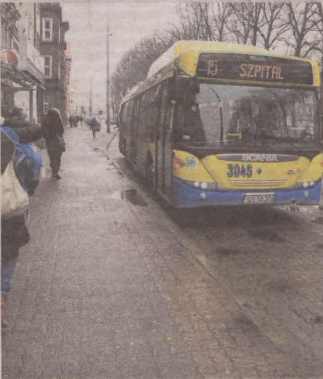
• Zniszczona zatoka przy al. Sienkiewicza. Mieszkańcy domu obok chcą jej remontu i wywołali problem w mieście
