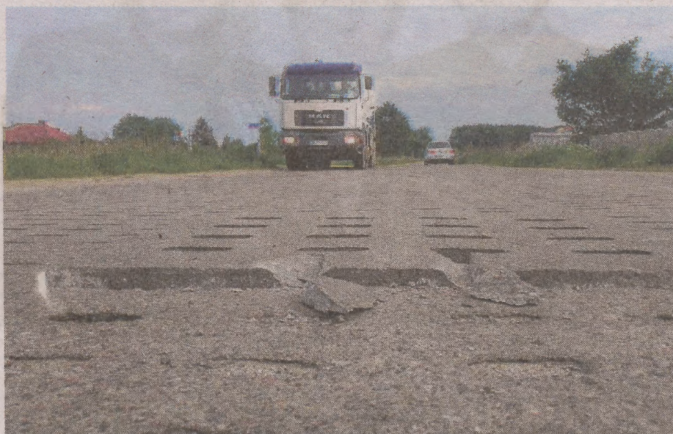
Jak informuje Zarząd Infrastruktury Miejskiej, nawierzchnia drogi na ul. Lawendowej zostanie naprawiona. Pojawią się też znaki ograniczenia tonażu aut
