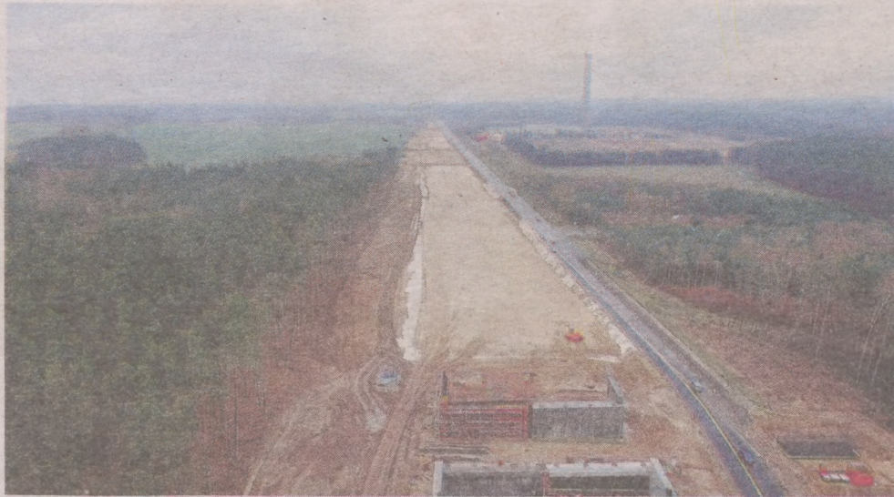
Budowa trasy S6 w okolicach Sianowa. Nowy odcinek miałby powstać między Karnieszewicami a Lęborkiem
