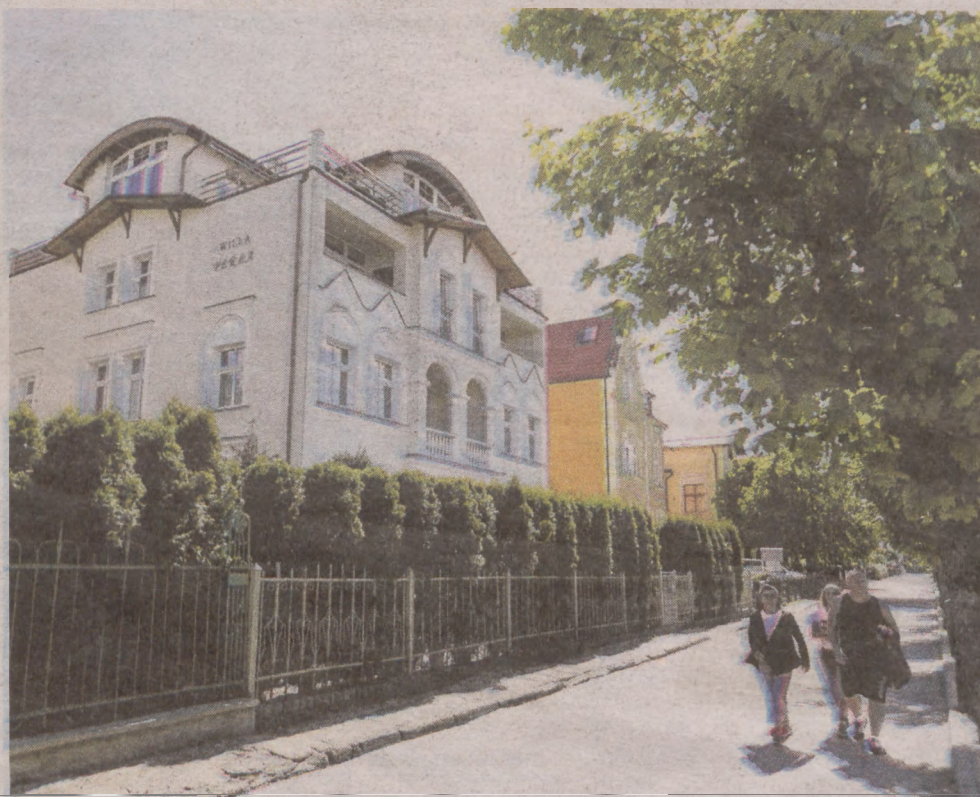
Nowi właściciele domów i mieszkań w Międzyzdrojach wyremontowali zrujnowane kamienice
