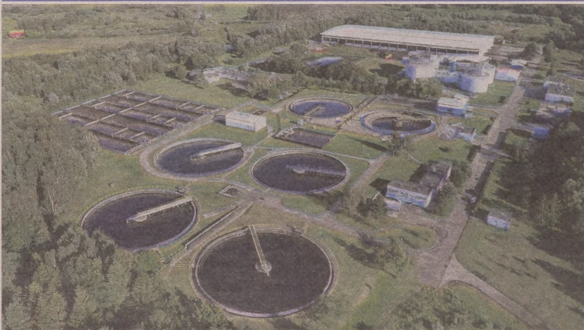
Oczyszczalnia ścieków w Słupsku.
