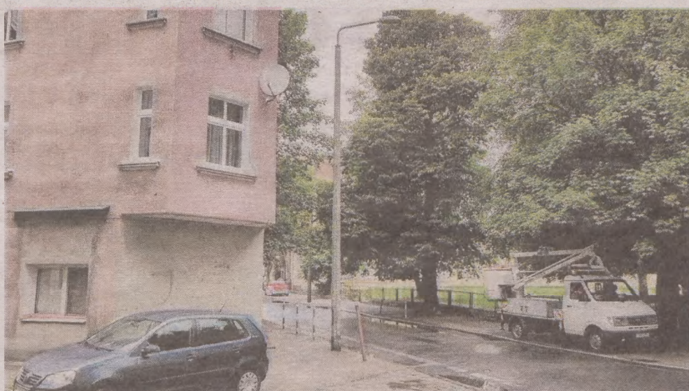
W ciągu dnia w ubiegłym tygodniu Energa naprawiała popuszczone lampy uliczne w Słupsku
