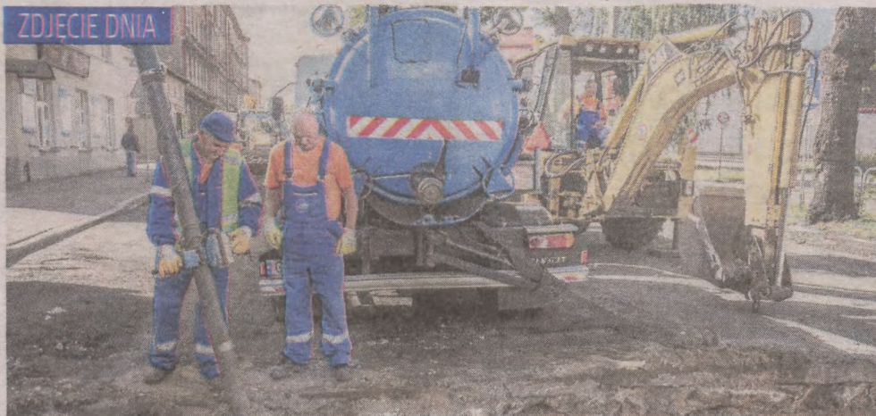
Trwają prace przy remoncie ul. Tuwima w Słupsku od placu Dąbrowskiego do skrzyżowania z ul. Kołłątaja. Po zerwaniu asfaltu do akcji wkroczyła ekipa Wodociągów Słupsk, która zajęła się wymianą przyłączy wodociągowych oraz regulacją wpustów kanalizacji deszczowej. (wf)
