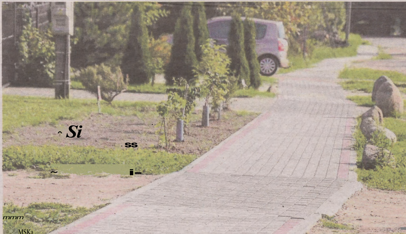
Na zdjęciu chodnik przy ulicy Kościelnej w Sycewicach. Jego budowa była możliwa dzięki inicjatywie lokalnej społeczności, która polegała na zgłoszeniu pomysłu budowy chodnika jako jednego z zadań do Kobylnickiego Budżetu Obywatelskiego 2018
