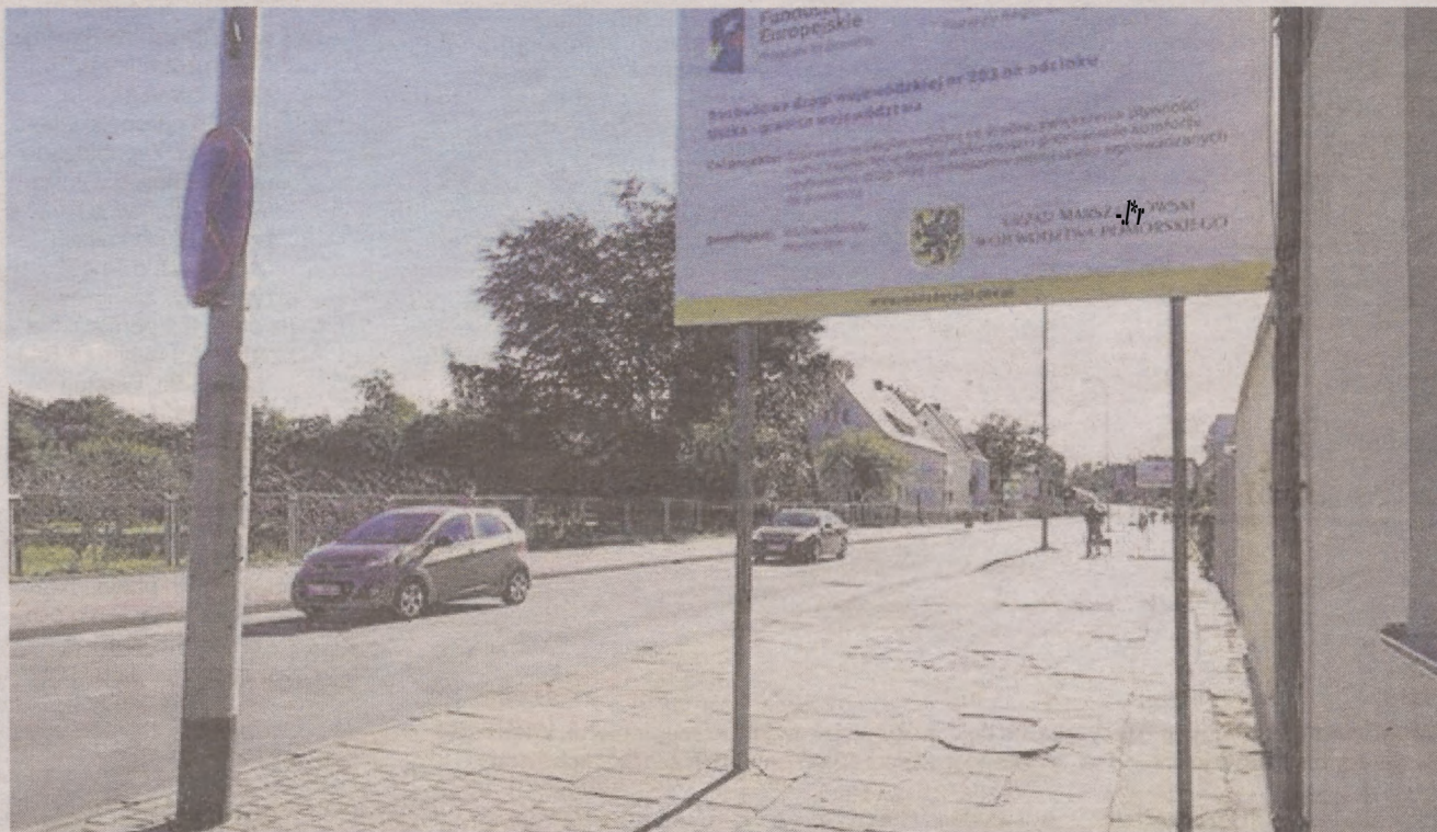
Na ulicy Darłowskiej w Ustce tablice informujące o źródłach finansowania już stoją. Wykonawca przygotowuje projekty objazdów i poszukuje wykonawców. Prawdopodobnie, ale nie na pewno, w Ustce roboty rozpoczną się w listopadzie
