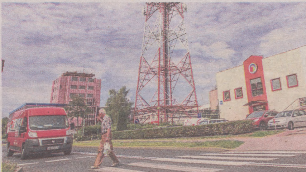
Mimo zapewnień mieszkańcy Poblöcia obawiają się, że wieża może negatywnie wpłynąć na ich zdrowie. Ze stacjami bazowymi GSM walczyli też mieszkańcy w Słupsku
