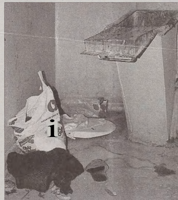
Legowiska bezdomnych nie wywołują zdziwienia wśród lokatorów budynków.
