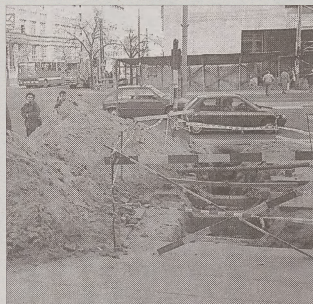
Na ul. 10 Lutego wkopanych zostanie kilometr rur. Fot. Mirosław Śmigaj
