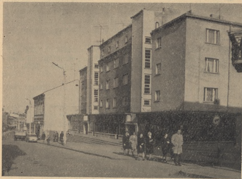
Wałecz — nowy budynek przy ul. Kilińszczaków z zapleczem usługowym.
