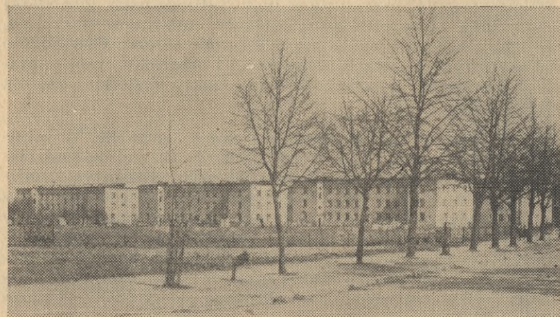
Wałcz — ul. Polowa — zagłębienie nowego budownictwa mieszkaniowego.
