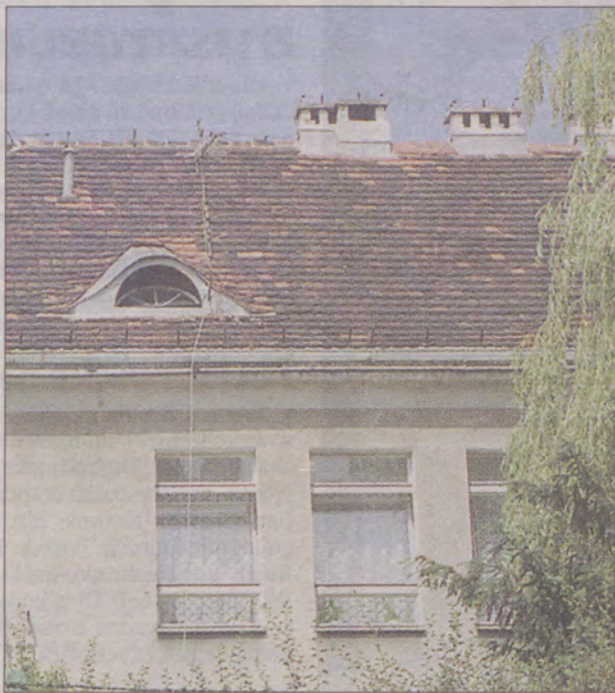
Na poddaszu budynku przy ul. Fredry 3 wiosną przyszłego roku powstaną mieszkania chronione.
