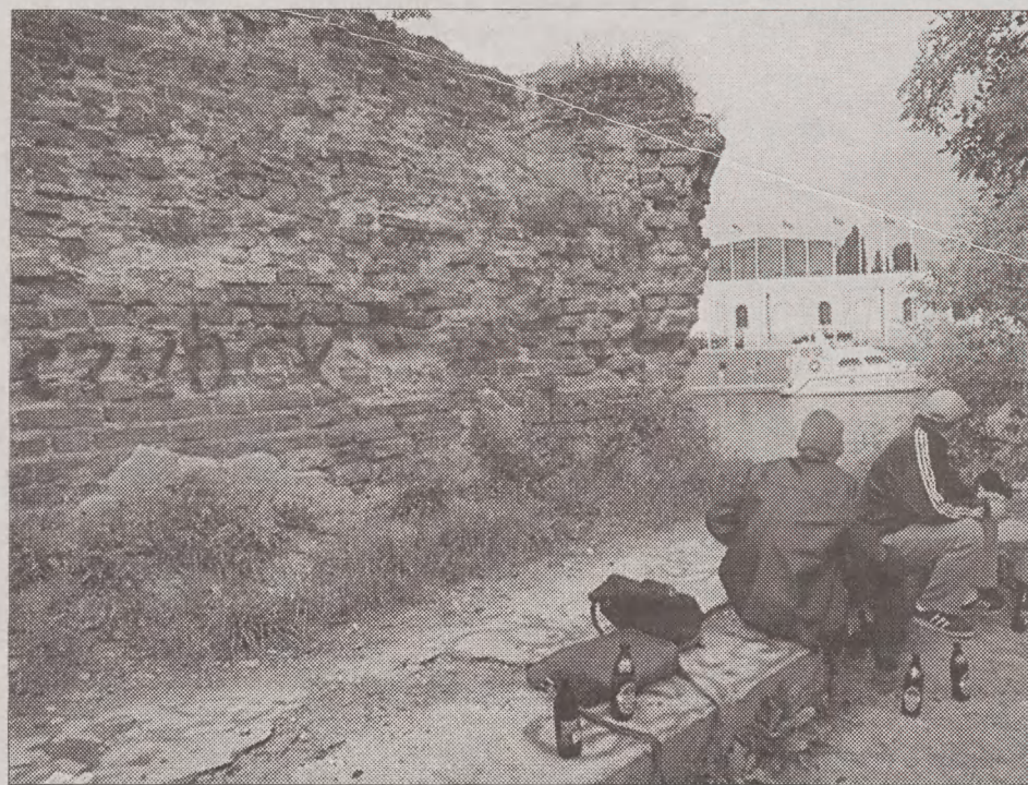
Zabytkowe ruiny spichlerzy na Wyspie Spichrzów zostaną zabezpieczone przed wandalami.
