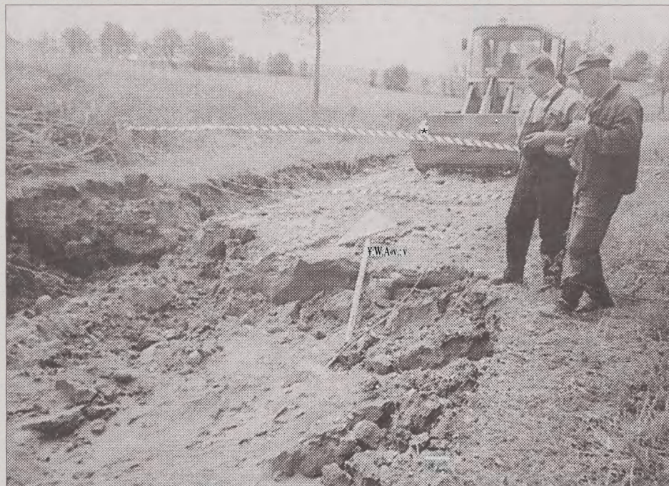
Niedawno zostały ukończone prace przy naprawie dróg prowadzących do miejscowości Dąbrówka, które były najbardziej zniszczone i w ogóle nieprzejezdne.
