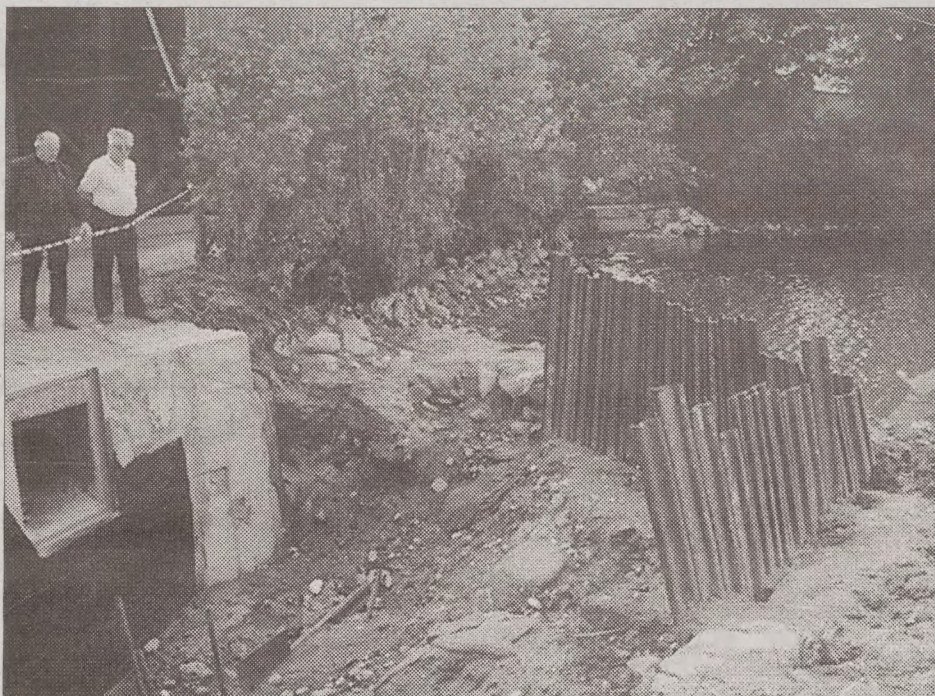
Przy wieprznickim młynie powstaje nowy przepust.
