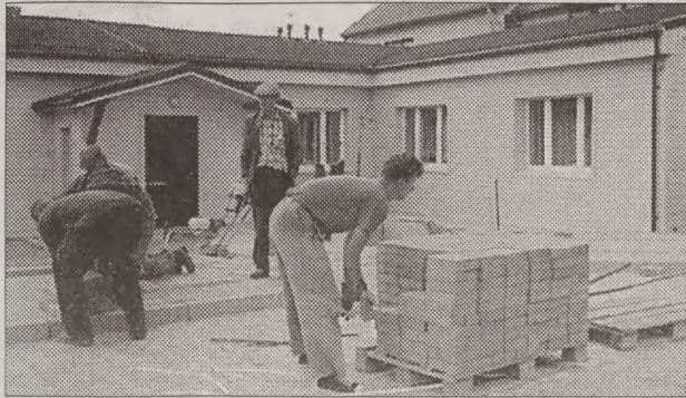
Prace przy wymianie i układaniu chodników trwają.
