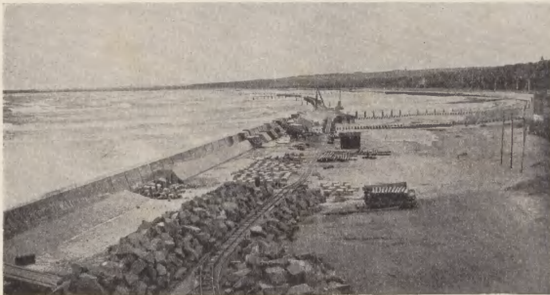
Abb. 11. Uferschutzwerke am Oststrande 1908.
