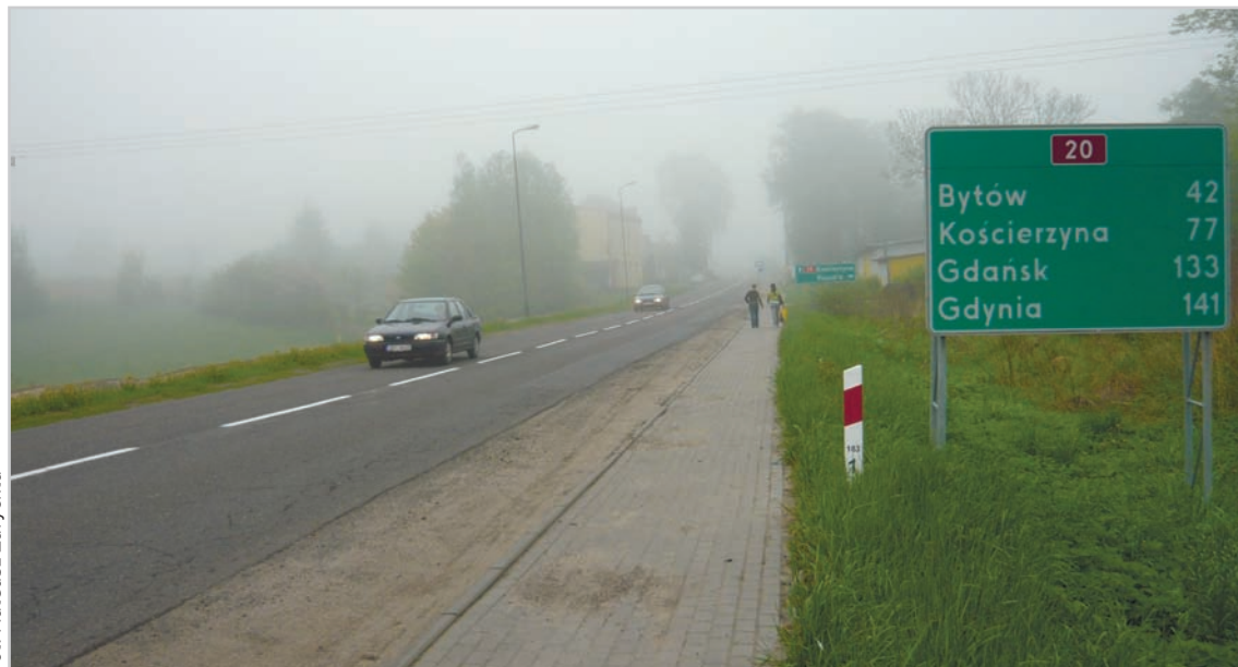
Kierowcy muszą jeszcze poczekać. W tym roku nie będzie planowanego remontu drogi między Miastkiem a Bytovem.
