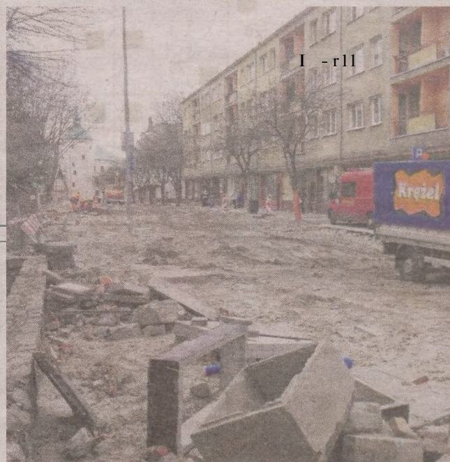
Ulica Mostnika jest przebudowywana, stąd utrudnienia
