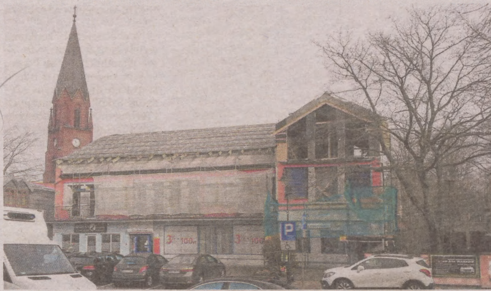
Trwa remont budynku Cechu Rzemiosł Różnych w Słupsku. Powstaną tu apartamenty
